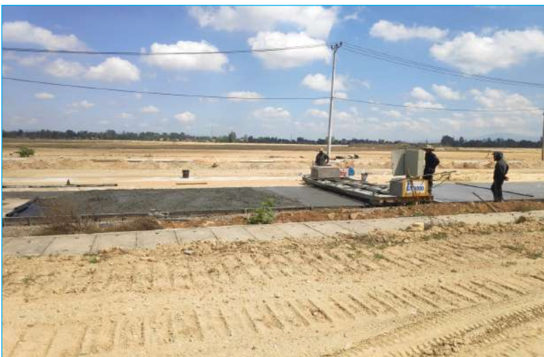
Hình ảnh thi công thực tế tại hiện trường KCN Nhơn Hòa giai đoạn 2
