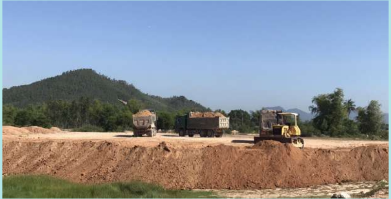
Hòa Hội đang thi công san nền lô N08 - ngày 04/8/2020
