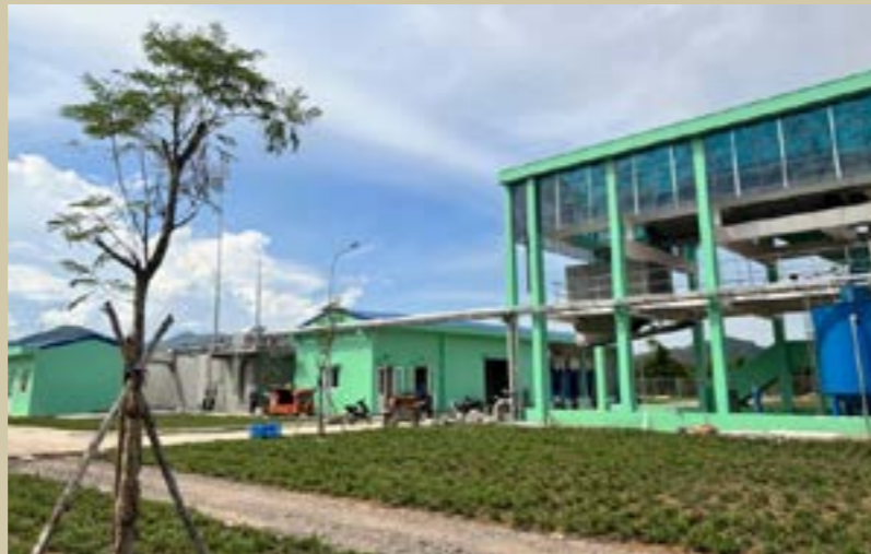
Công trình Khu xử lý nước thải tập trung
