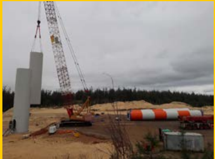
Thi công trụ Tuabine tại dự án Nhà máy Phong điện Phương Mai 1
