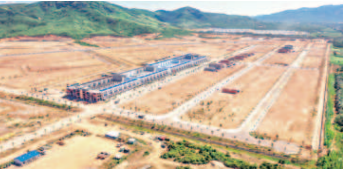
KCN đang được xây dựng khẩn trương đồng bộ hiện đại
