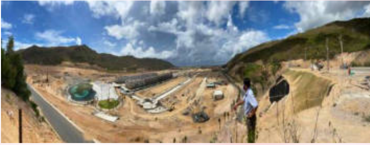
Toàn cảnh công trường Dự án Tổ hợp dịch vụ thương mại giải trí Merry Land Quy Nhơn
