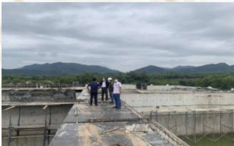
Công trường xây dựng Khu xử lý nước thải tập trung
