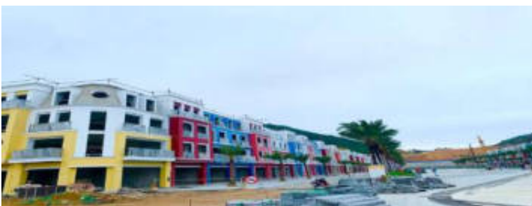
Chủ đầu tư đang tích cực triển khai xây dựng trên hiện trường
