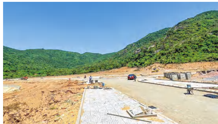
Hiện trạng một phần dự án Khu dân cư và tái định cư Vĩnh Hội đang thi công
