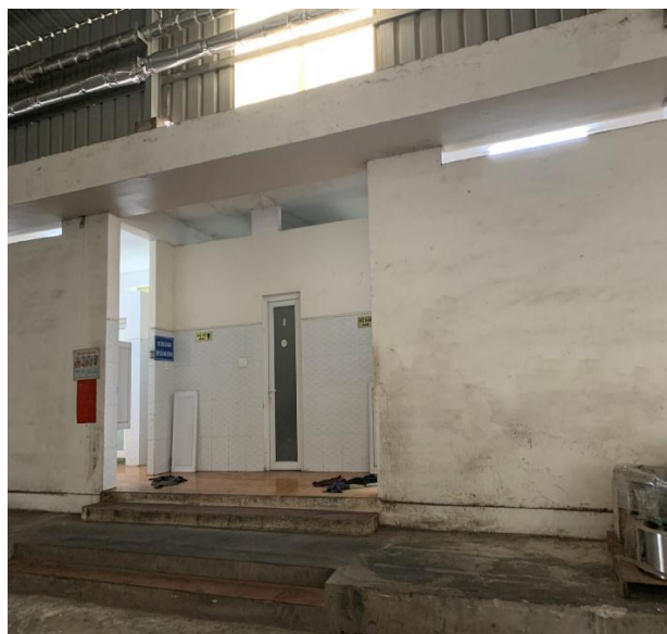
Hình 4.7. Nhà vệ sinh khu vực sản xuất của Nhà máy
