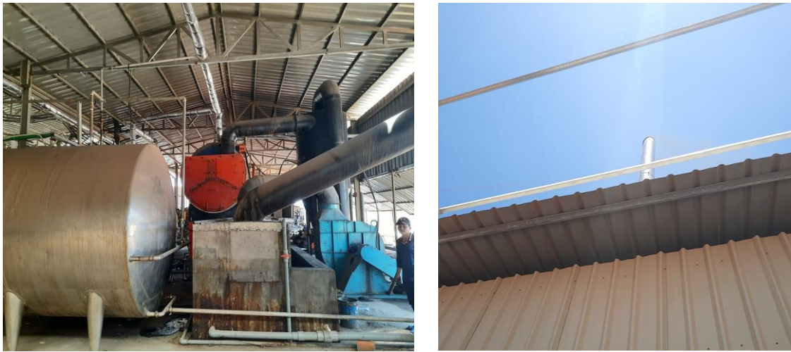
Hình 4.4. Hệ thống xử lý khói thải lò hơi và ống thoát
