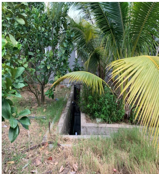
Hình 4.22. Hệ thống thu gom nước mưa Nhà máy và đưa về điểm đầu nối M3 phía Nam đường N3
