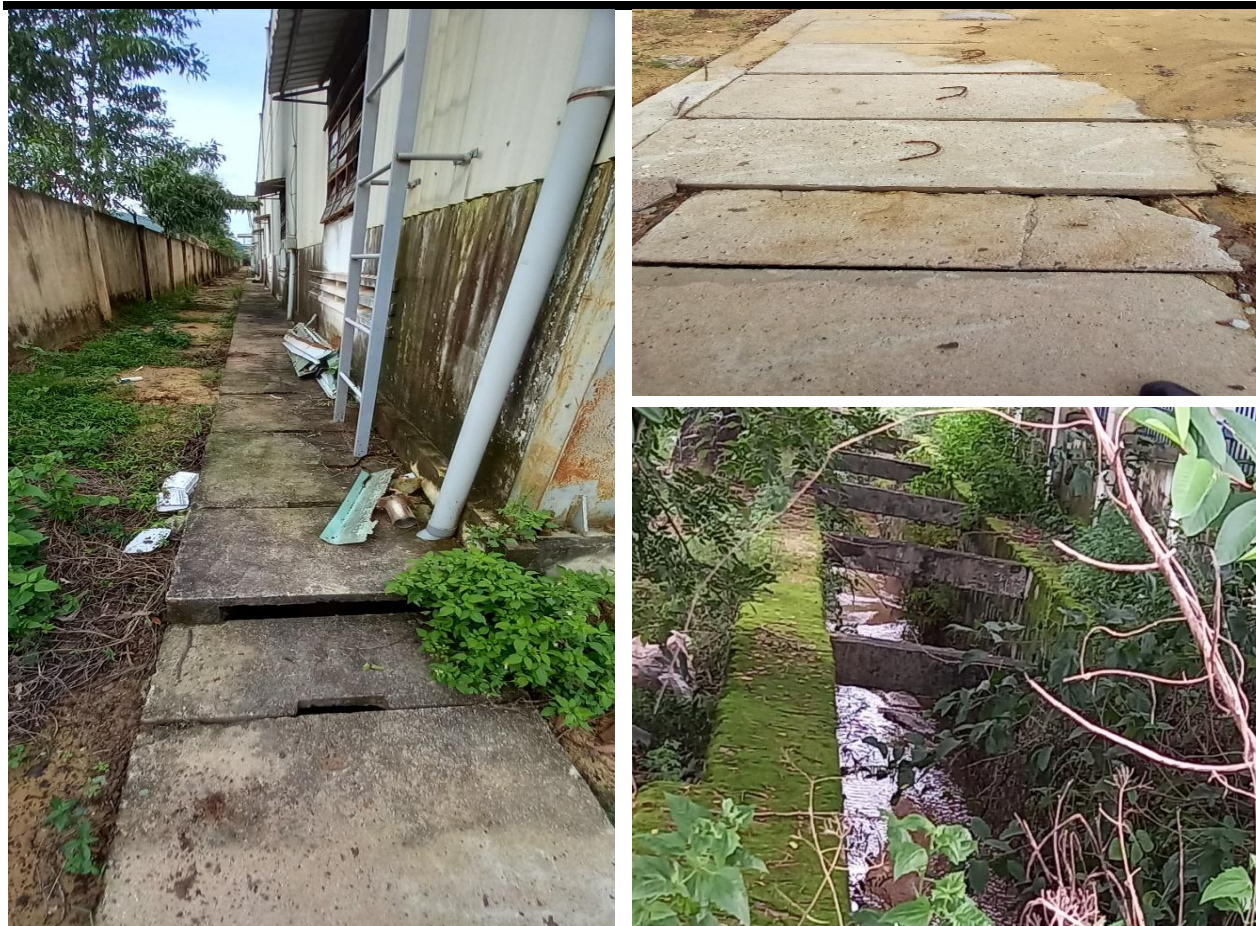
Hình 3.1. Một số hình ảnh thoát nước mưa tại dự án
