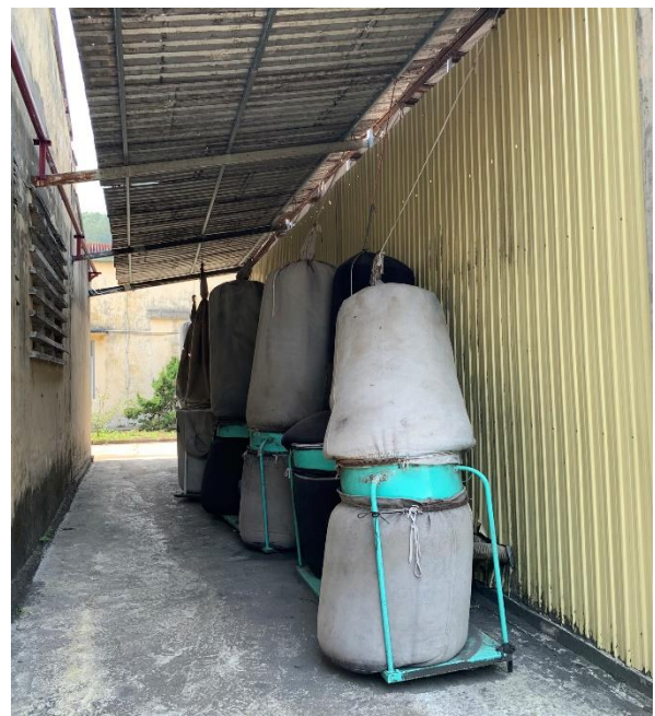
Hình 11. Hệ thống lọc bụi túi vải tại nhà máy
