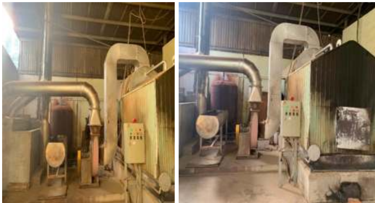
Hình 3. 9. Hệ thống xử lý khói thải nồi hơi
