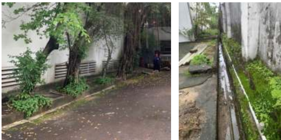
Hình 3. 2. Mương thoát nước mưa hiện hữu xung quanh nhà máy
