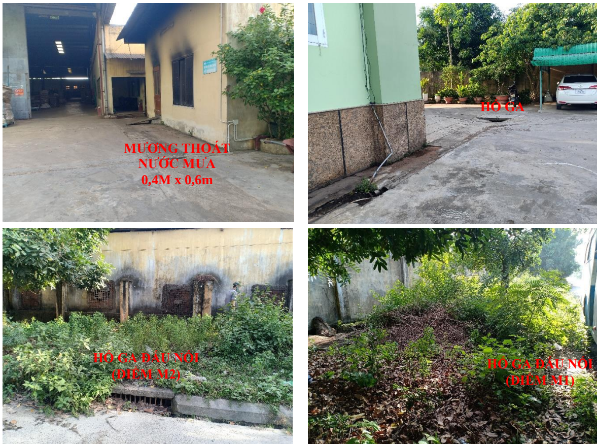
Hình 3.2. Mương thu gom, thoát nước mưa của Nhà máy
