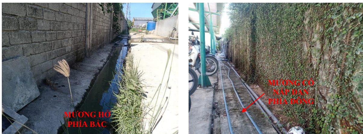
Hình 3.2. Mương thoát nước mưa
