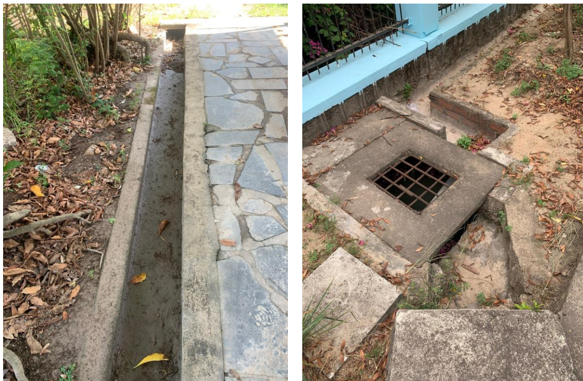
Hình 3. 2. Mương thoát nước mưa hiện hữu xung quanh nhà máy
