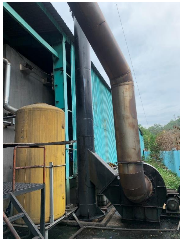
Hình 3. 9. Hệ thống xử lý khói thải lò đốt
