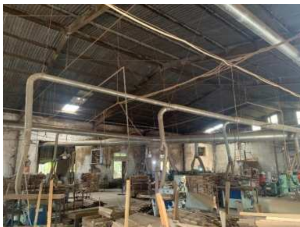
Hình 4. 4. Hệ thống thu gom và xử lý bụi nhà xưởng
