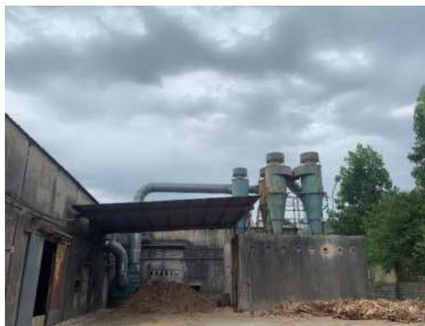
Hình 4. 4. Hệ thống thu gom và xử lý bụi nhà xưởng
