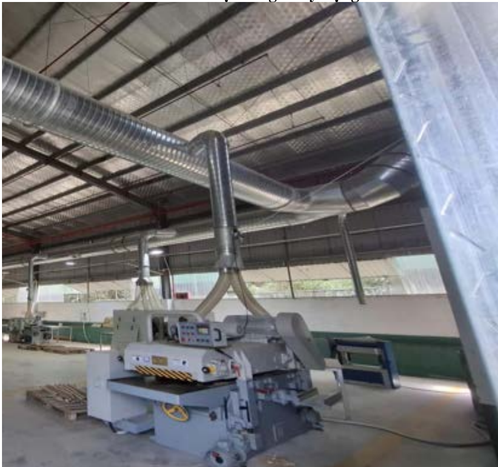
Hình 4. 7. Hệ thống đường ống thu gom bụi gỗ.
