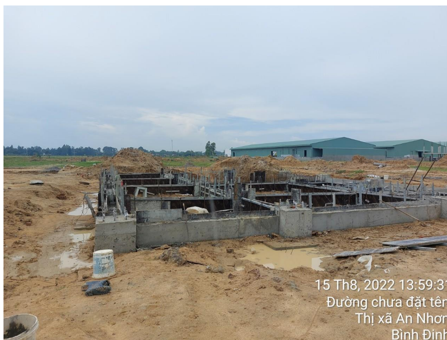
Hình 1. 3 Một số hình ảnh hiện trạng đang triển khai xây dựng tại dự án Các hạng mục công trình đang triển khai xây dựng tại dự án bao gồm:
