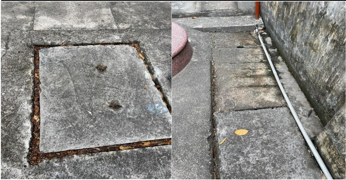
Hình 6. Hồ gas, mương thoát nước mưa tại nhà máy
