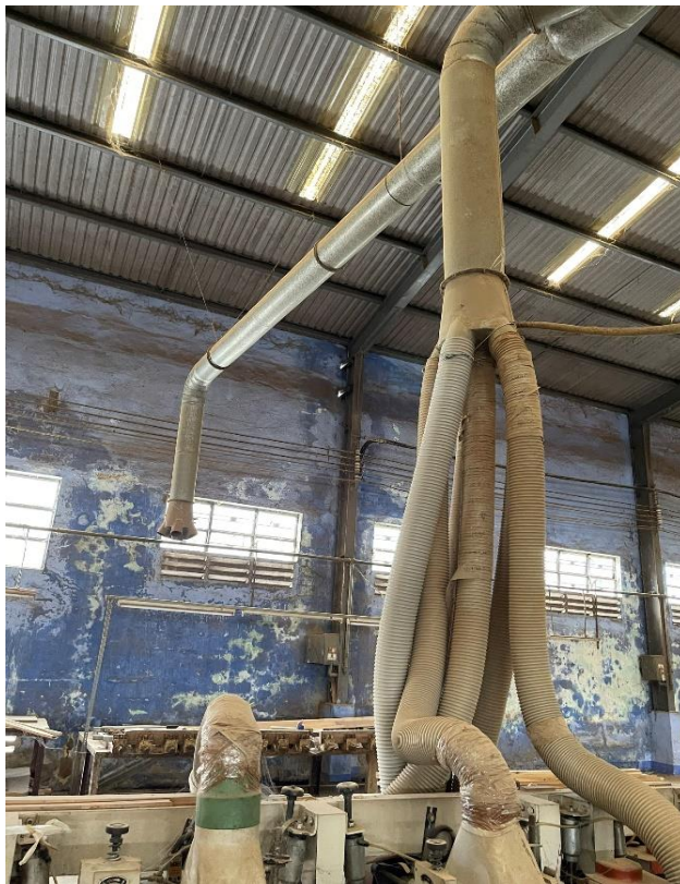
Hình 13. Hình ảnh hệ thống thu gom bụi tại nhà máy
