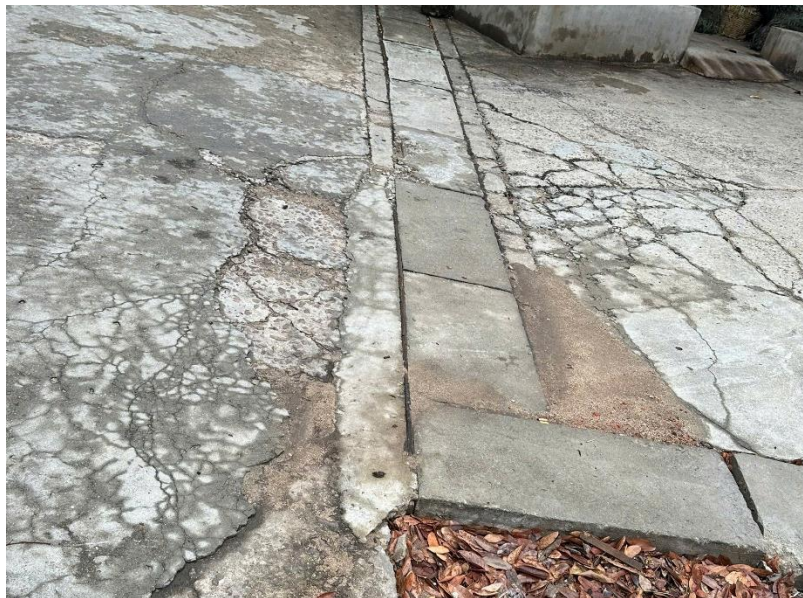
Hình 3.2. Hệ thống thu gom nước mưa.
