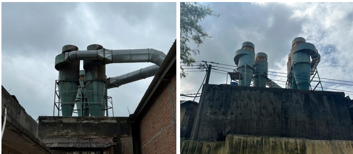
Hình 3.8. Cùm 4 cyclones xử lý bụi và nhà chứa bụi.
