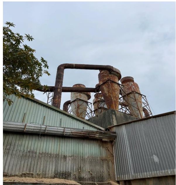
Hình 12. Hình ảnh hệ thống thu gom bụi tại nhà máy
