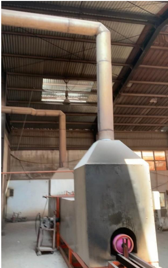
Hệ thống thu hồi bụi, khí thải từ quá trình đốt sơn vỏ chai
