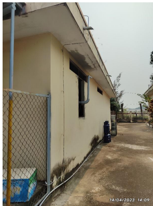
Ống khói máy phát điện
