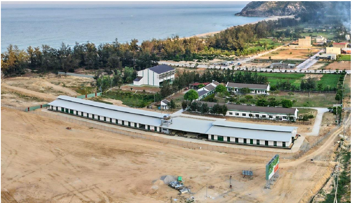
Các công trình đã được xây dựng thuộc khu 1
