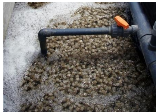
Hình IV.16. Mô hình minh họa xử lý nước thải bằng công nghệ MBBR
