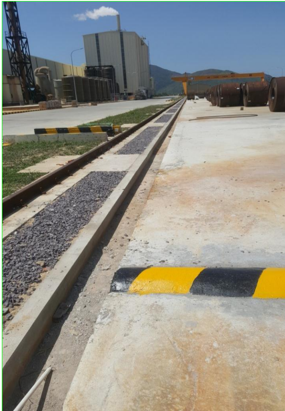
Hình 3. 5 Rãnh thu nước mưa tại Bãi chứa nguyên liệu cán nóng (HR) về HTXL NTSX
