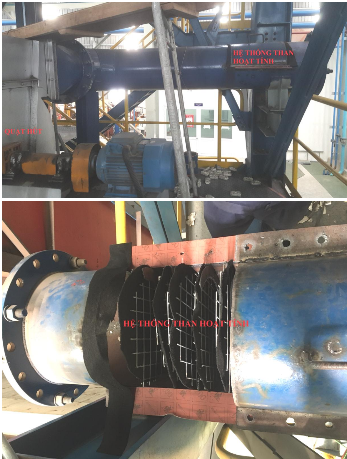
Hình 3. 20 Hệ thống xử lý hơi antifinger chuyên Nof 1
