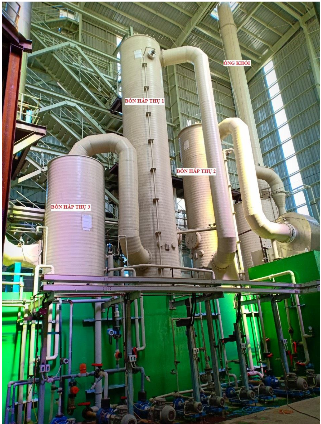
Hình 3. 16 Cột hấp thụ xử lý hơi axit phát sinh từ hệ thống tái sinh axit
