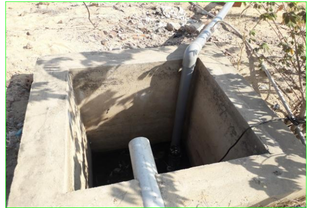
Hình 3. 6 Hồ gas thu nước mưa Bãi chứa phế liệu và Bãi chứa Xỉ nhôm, xỉ kẽm
