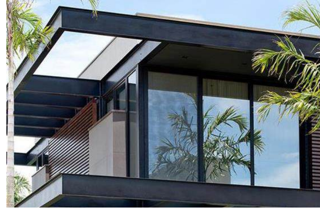
Khung sắt I nhấn mạnh đường viền công trình
